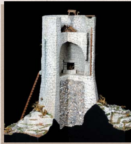
Maqueta en la que se muestra la construcción de una torre de planta circular.
